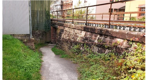
Abbildung 11: Bahntrasse entlang des Bootsbaubetriebes
