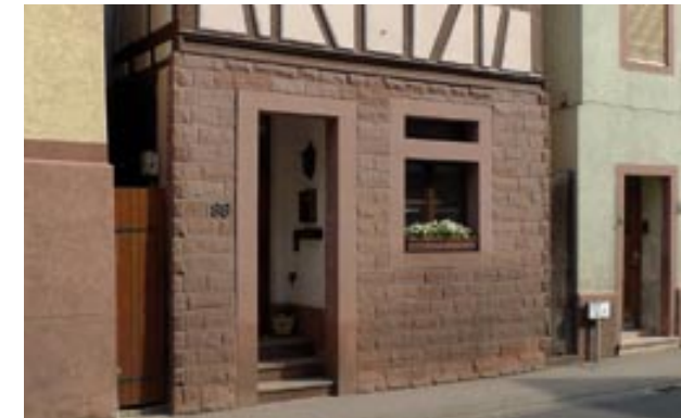
Lochartiger Hauseingang mit eingerückter Treppe [34]
