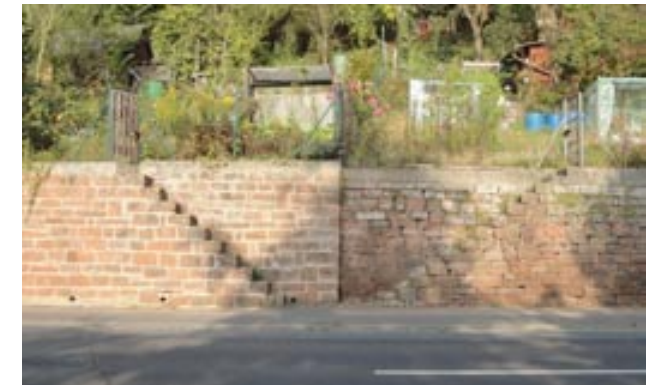
Stützmauern aus Rotsandstein
