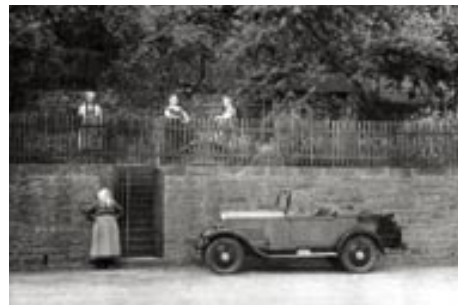
Gartennutzung ehem. Weinbergterrassen [49]
