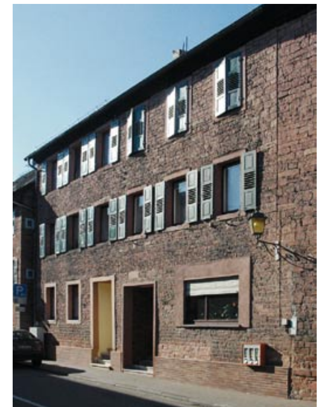
Natursteinfassade aus Rotsandstein [18]
