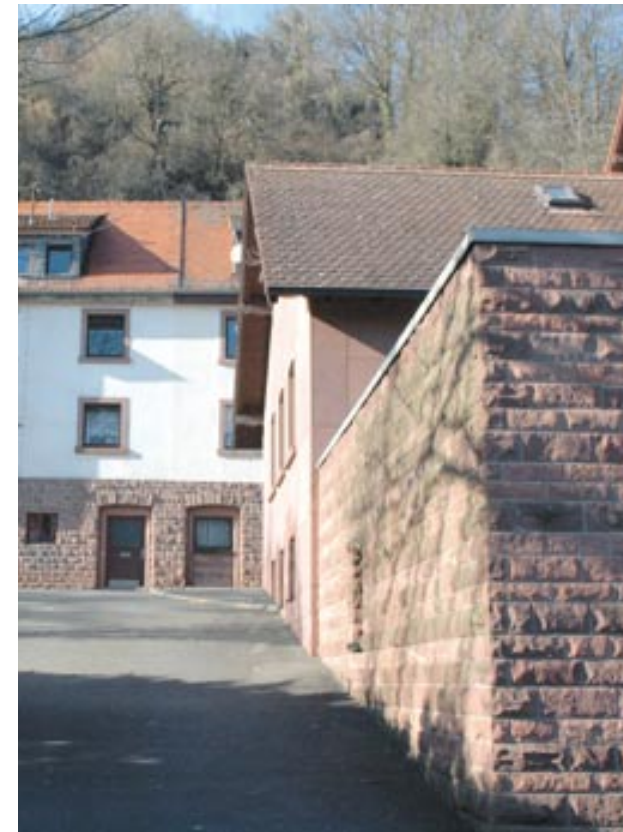
Anbau entspricht der Materialität des Hauptgebäudes [56]
