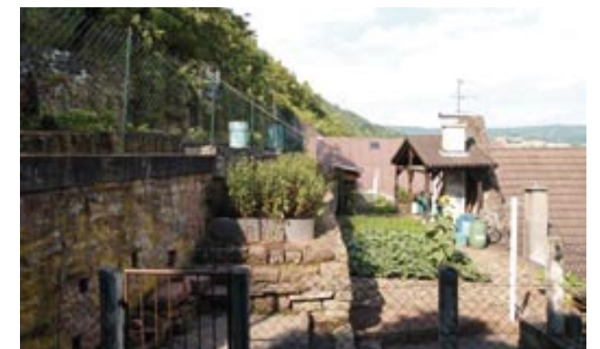
Terrassengärten auf der Hangseite
