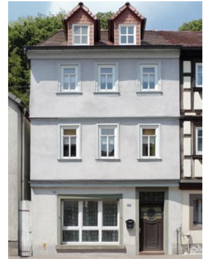
Verputzter Fachwerkbau in Mischbauweise [16]
