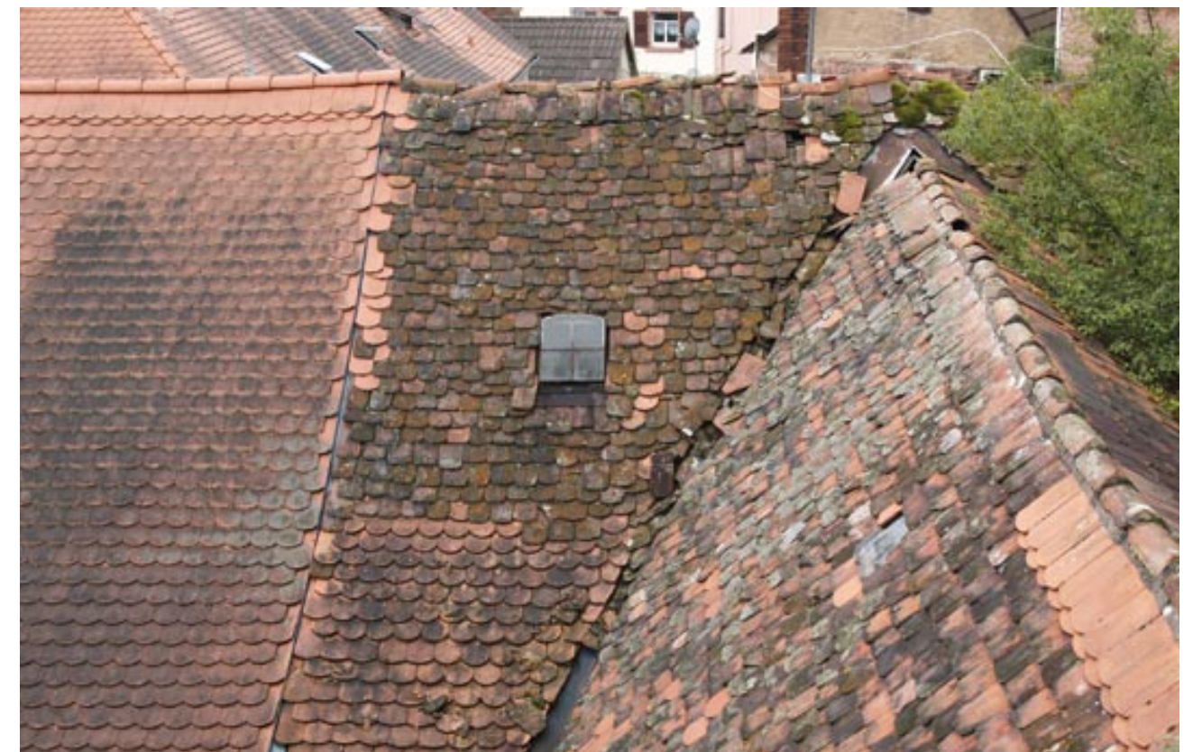
Dachdeckung mit Biberschwanzziegeln
