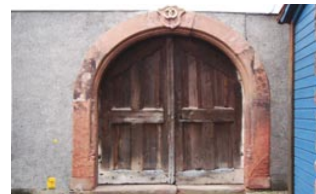
Historisches Rundbogenportal zum Kellergeschoss [38]
