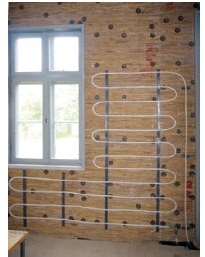
Montage Wandflächenheizung an einer Außenwand [26]
