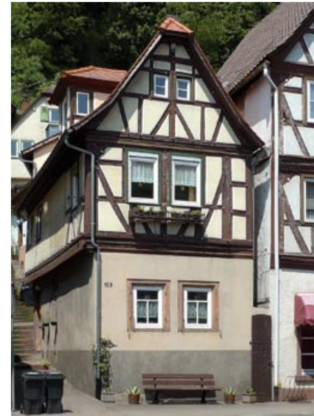
Fachwerkbau in Mischbauweise mit Sichtfachwerk [15]
