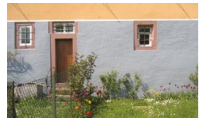
Garten im Bereich der ehemaligen Stadtmauer
