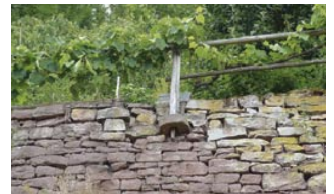
Detail Kragstein innerhalb der Stützmauer
